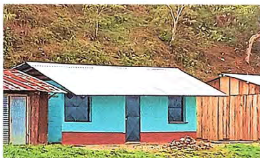
Foto 3: Se observa cocina ampliada.
