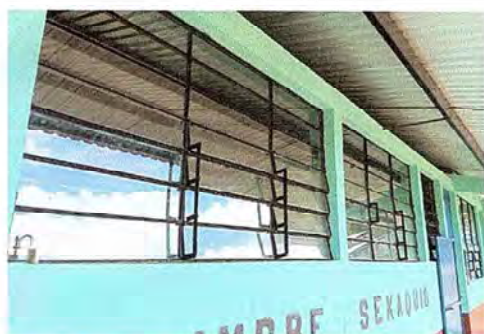
Foto1: Escuela con vidrios nuevos.
