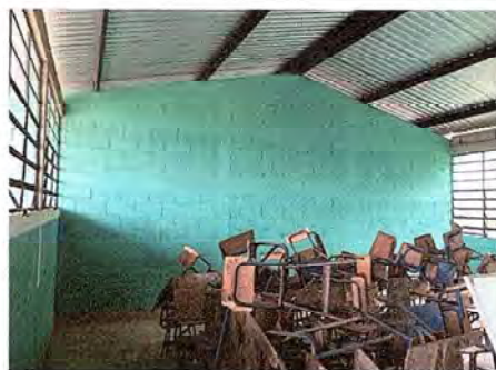
Foto 4: Pintura dentro de las aulas en buen estado.
