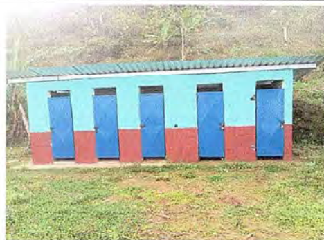
Foto 2: Sanitario en buen estado, con techo, pintura y puertas nuevas.
